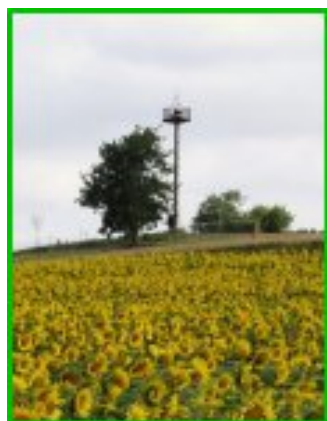
Vue du phare aéronautique de Baziège, côté Est avant la construction du lotissement.
